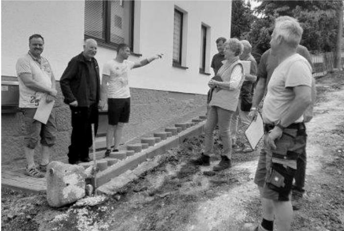
Der obere Abschnitt der Straße „Am Hang“ im Ortsteil Bärenwalde wird seit zwei Monaten ausgebaut. Auf einer Länge von 170 Metern wird eine geordnete Straßenentwässerung geschaffen und die Straße mit einem Asphaltbelag versehen. Im Zuge der Bauarbeiten wird - im Auftrag des Unternehmens UGG - zudem auch Breitbandkabel verlegt werden.
